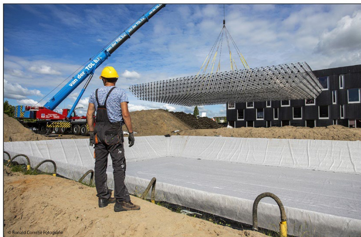
Figuur 10: Voorbeeld hoog/midden-temperatuur warmteopslag
