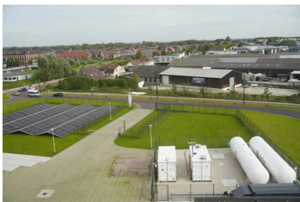
Figuur 11: Voorbeeld waterstofcentrale met PV-panelen
