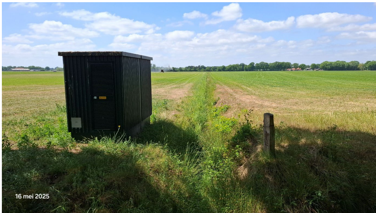
Foto: Zicht op het elektriciteitshuisje halverwege de Kerkweg.
