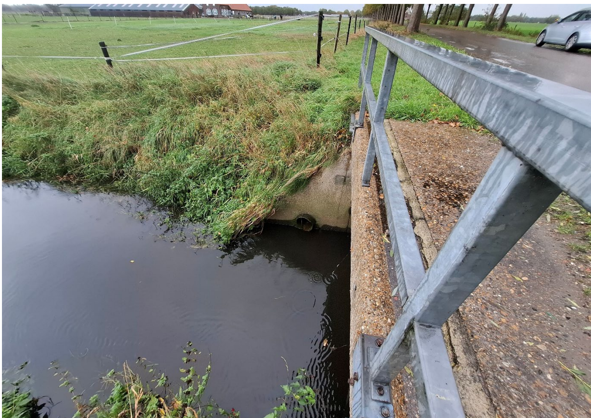
Foto: Zicht vanaf de Heijbeeksestraat bij de Kleine Aa van de duikerbrug met een open duiker naar de watergang langs de Heijbeeksestraat.
