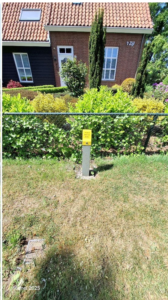
Foto's: Zicht op de paaltjes van de hoge- en lage drukleiding voor gas en Enexis (oliedrukkabel, hoogspanning) aan de Oude Turfvaartsestraat 52.
