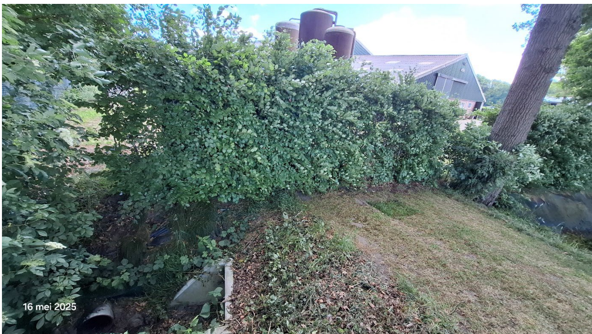
Foto: Zicht op het werkterrein van de Oude Turfvaartsestraat 51 met een hemelwaterafvoer en betonconstructie voor de duiker onder de dam.
