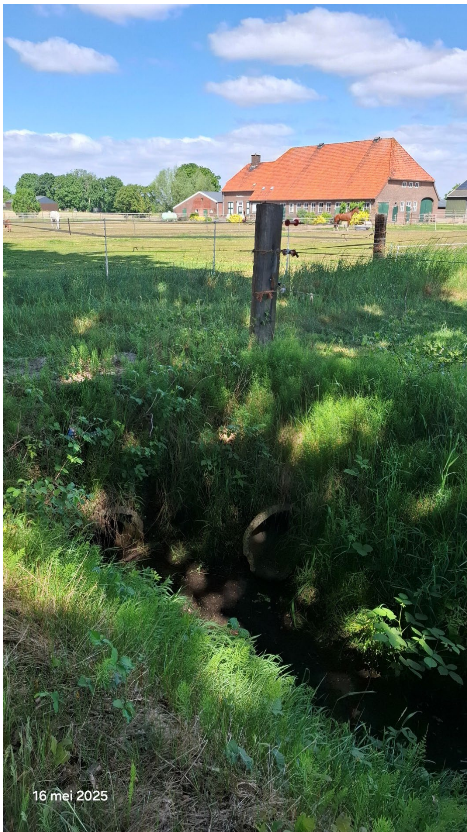
Foto: Zicht vanaf de Heijbeeksestraat op een extra aanwezige duiker naar de watergang dwarsop richting de schuur bij de Heijbeeksestraat 5.
