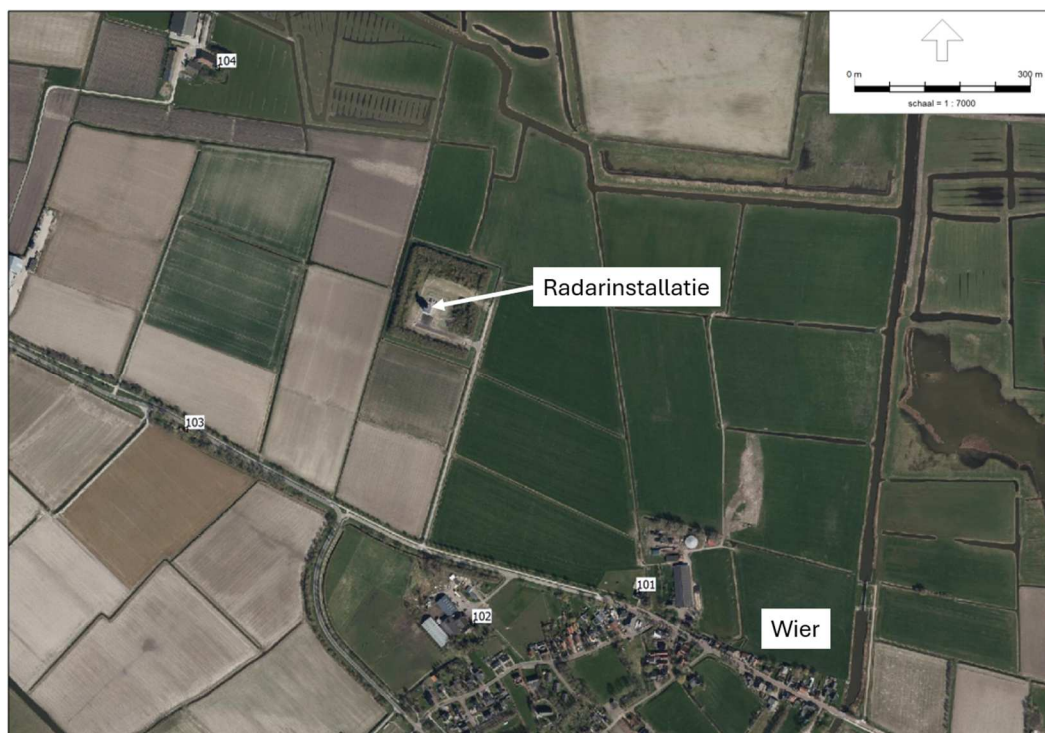
f 2.1 Situatie van de radarinstallatie te Wier
